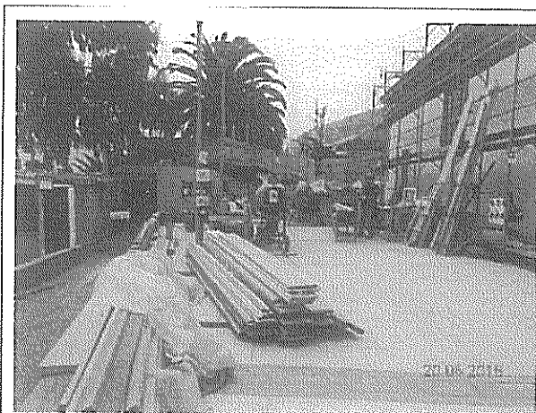
Fotografía N° 19: Ocupación de lote N° 4, costado Iglesia sin autorización.
