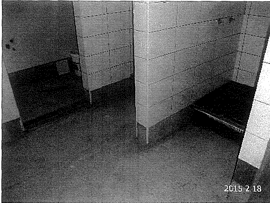
Fotografía 7, Pavimento sin instalar. Reposición Centro de Salud, Punitaqui.
