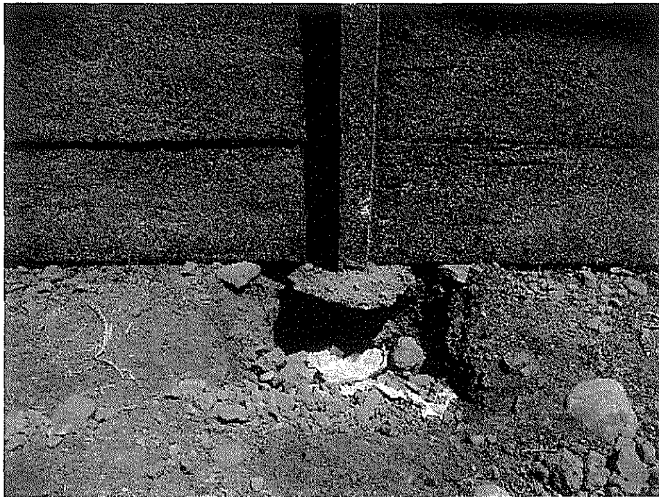
Fotografía 4, fundaciones del cierre de placas prefabricadas de hormigón que no cumplen lo determinado en las EE.TT. Reposición Centro de Reinserción Social de Ovalle.
