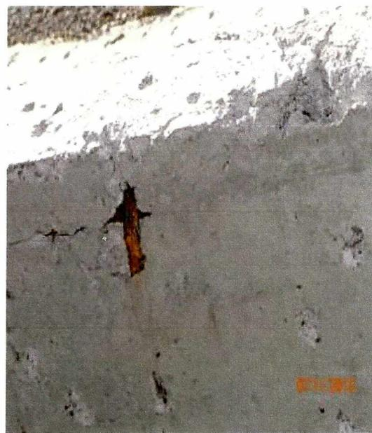
Fotografía N° 24: Fierro a la vista con presencia de óxido, bloque E.
