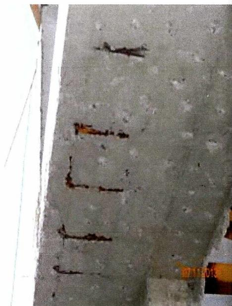
Fotografía N° 23: Fierro a la vista con presencia de óxido, bloque E.
