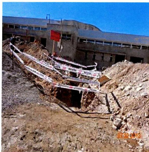
Fotografía N° 20: Seguridad de las excavaciones para instalaciones sanitarias.
