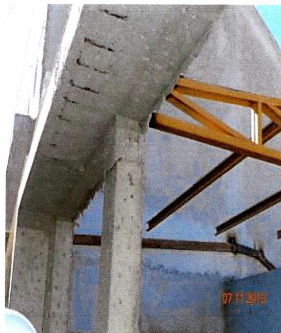
Fotografía N° 22: Fierro a la vista con presencia de óxido, bloque E.
