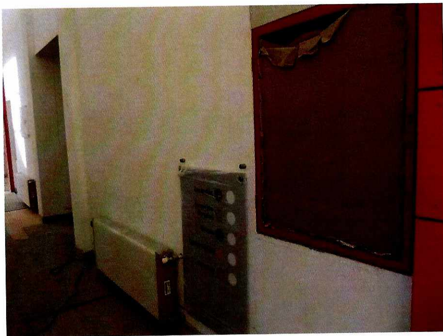
Fotografía N° 14: Descuadre en nicho de instalación de los gabinetes para mangueras
