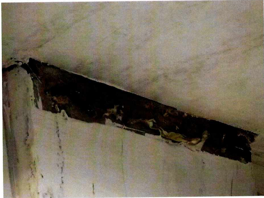
Fotografía N° 14: Descuadre en nicho de instalación de los gabinetes para mangueras
