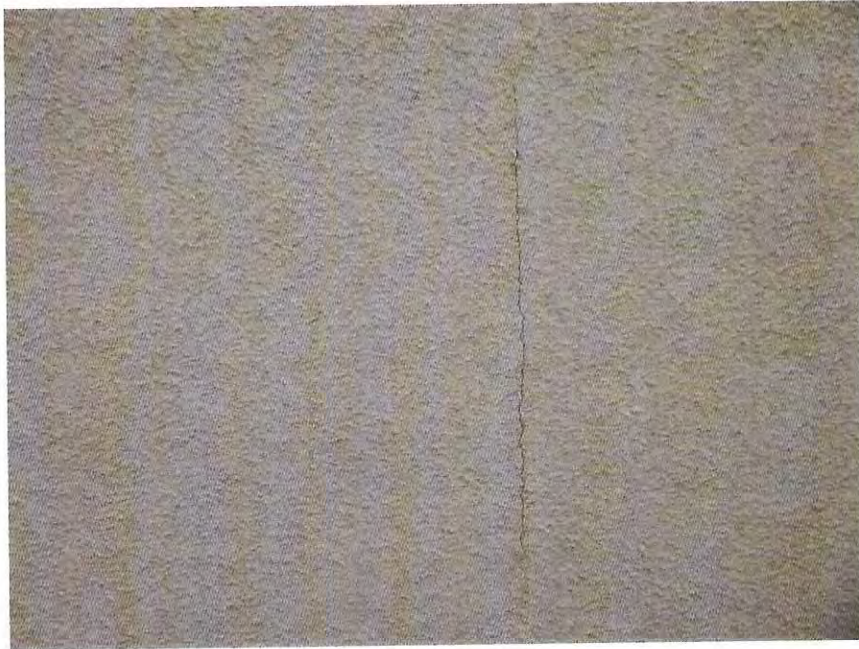
Fotografía N° 3: Fisuras en el muro del patio interior.
