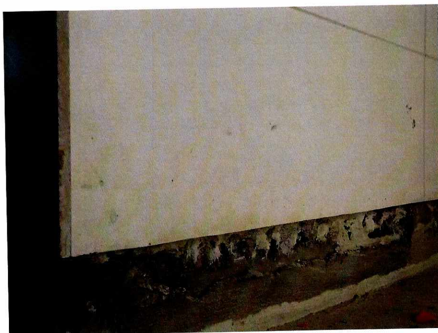
Fotografía N° 10: Malas terminaciones en zonas inferiores de los muros.
