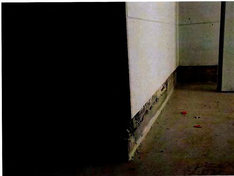
Fotografía N° 12: Desaplomo en pilar de la intersección de los ejes 20 y A.
