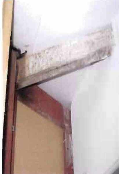
Soporte metálico oxidado bajo lavamanos baño del segundo Piso.
