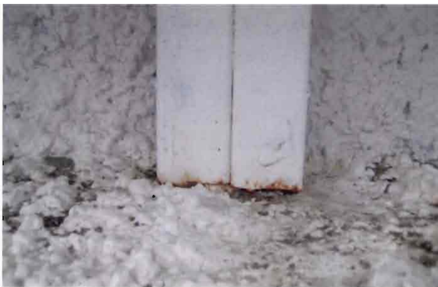
Oxido en quiebra-vista ventanas exteriores.
