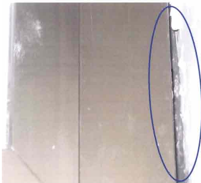
Falta sello en marco de ventana.
