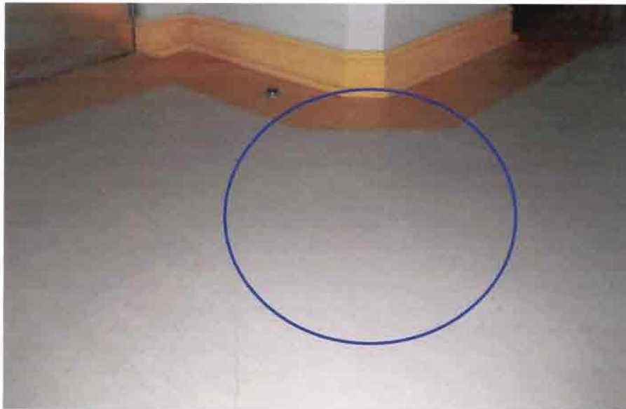
Reparación de englobamientos del piso vinílico.
