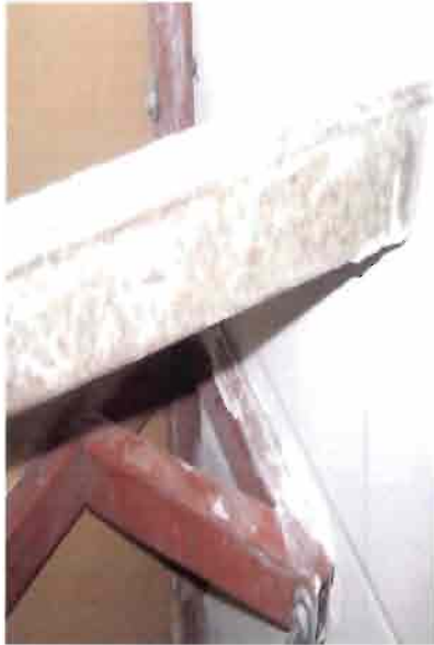
Soporte metálico oxidado bajo lavamanos baño del segundo Piso.
