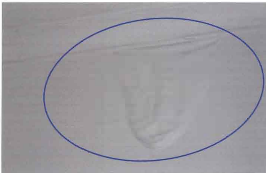
Si bien se restaura la pintura, no así la estanqueidad de la cubierta, ya que según se observa en esta fotografía el agua ha seguido escurriendo a través de la pintura.
