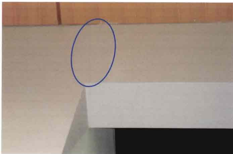
Reparación superficial fisura en eje B y eje 24.
