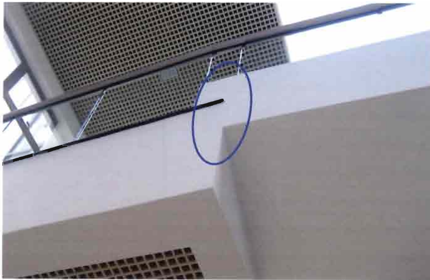
Reparación superficial fisura en eje O, con ejes 13 y 14.
