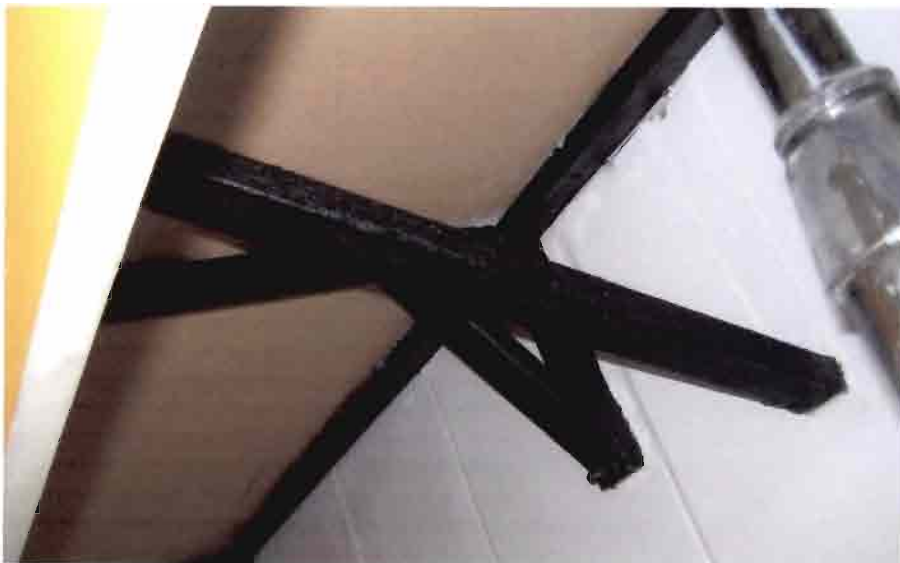
Soportes de lavamanos con protector de pintura.
