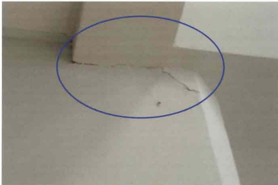
Fisura ubicada en encuentro entre eje E con eje 10.
