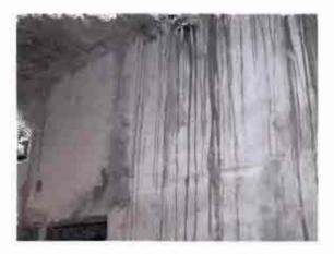
Fotografías N°s 7, 8 y 9. Desprendimiento de material, fisuras y grietas en muros y pilares. Se alcanza a distinguir la armadura de la estructura. Sector fachada acceso principal, bajo graderías norte y acceso a piscina desde camarines, respectivamente.
