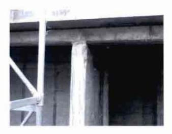
Fotografía N°10: Terminación de un pilar en el sector de las salas multiuso con hormigones de distintas edades. Se observan deficiencias en el modo de ejecución de las uniones, diferencias de espesores, terminaciones y adhesiones de mala calidad y excesos de material.
