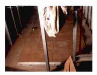
Fotografía N°18 Rajaduras y cortes en la lámina de polietileno de protección y aislación para las obras de fundaciones
