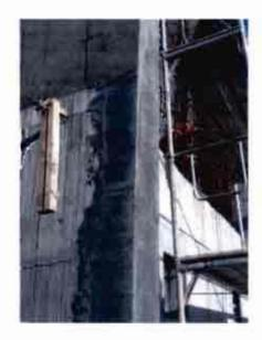
Fotografia N°11: Deficiencias en la unión de hormigones de distintas edades en el dintel de una puerta en el sector de camarines, baños y bodegas.
