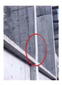
Fotografia N°2: Terminación no homogénea de un muro interior del sector de camarines, baños y bodegas, que evidencia una mala ejecución de los trabajos de moldajes y hormigonado.
