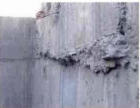
Fotografía N°6: Manchas superficiales en gran parte de los muros del proyecto, evidenciando la no utilización de desmoldantes.
