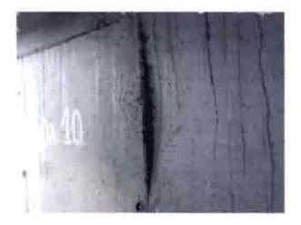
Fotografía N°3: Desaplome de un muro en el sector del gimnasio.
