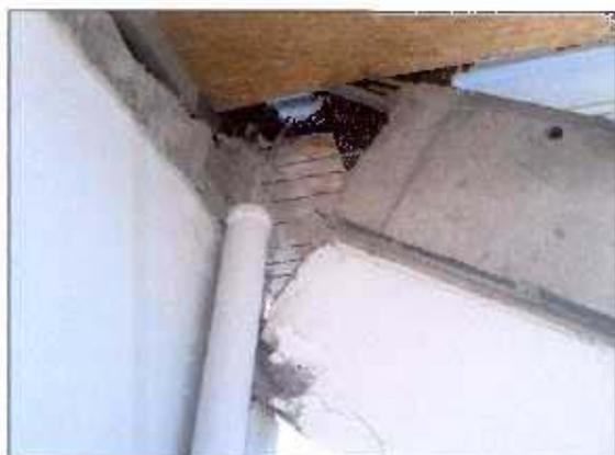
Foto N° 04: Desprendimiento de una viga desde el muro de anclaje en el edificio 2B.
